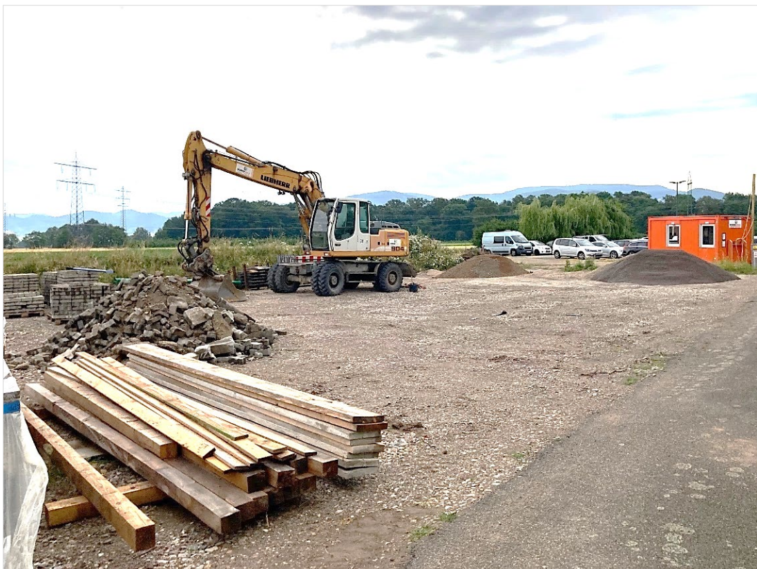
Abb. 6: Baustelleneinrichtungsfläche nördlich des Parkplatzes
