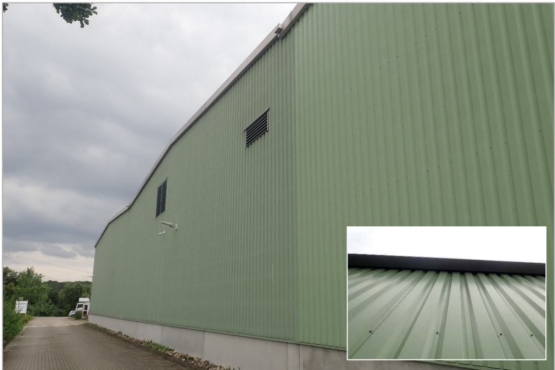
Abb. 7: Zu erweiternde Produktionshalle mit Hohlräumen zwischen Metallverkleidung und Fassade
